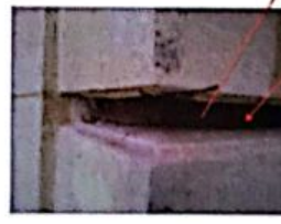
Picado de junta entre sillares - incorporación de barra de hierro en L evita futuro corte de mampostería y nueva aparición de grieta.
