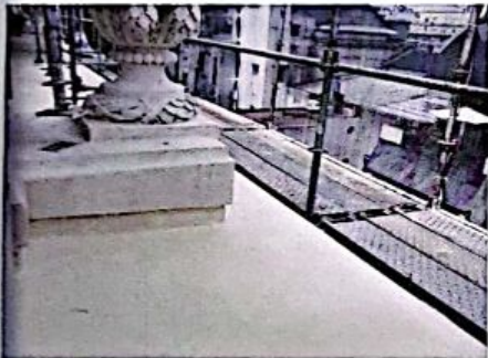
Solado sobre cornisa
