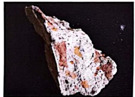
Material del contrapiso y revestimiento simil piedra original
